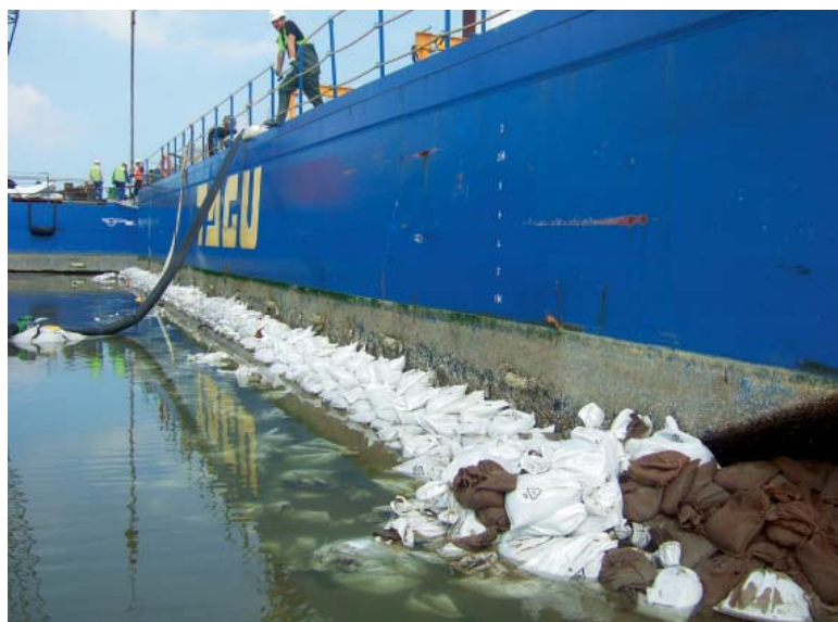
Fot. 5. | Strona rurowa – barka – obwarowana piaskiem
